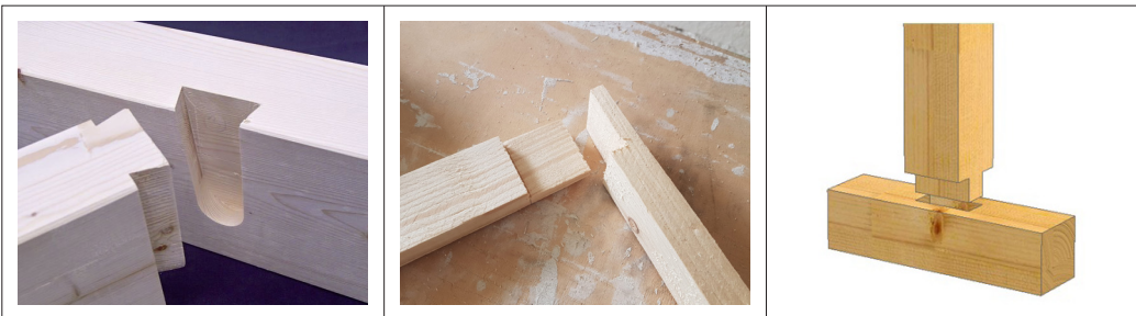
Schwalbenschwanz- Verbindung.....
